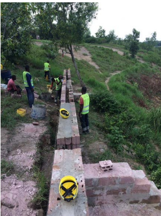
Water wordt ook gebruikt voor onze werkzaamheden ter plaatse (feb. 2020)
